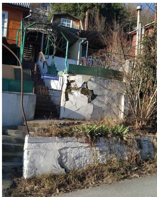
В) подпорная стенка участка Циолковского, 17а
