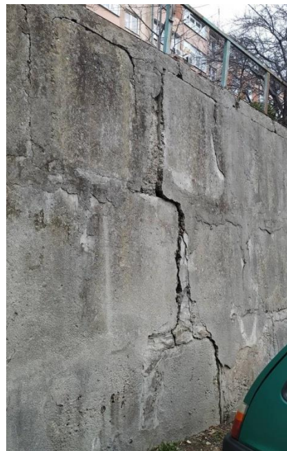
Б) подпорная стенка у жилого дома по адресу Партизанская, 38
