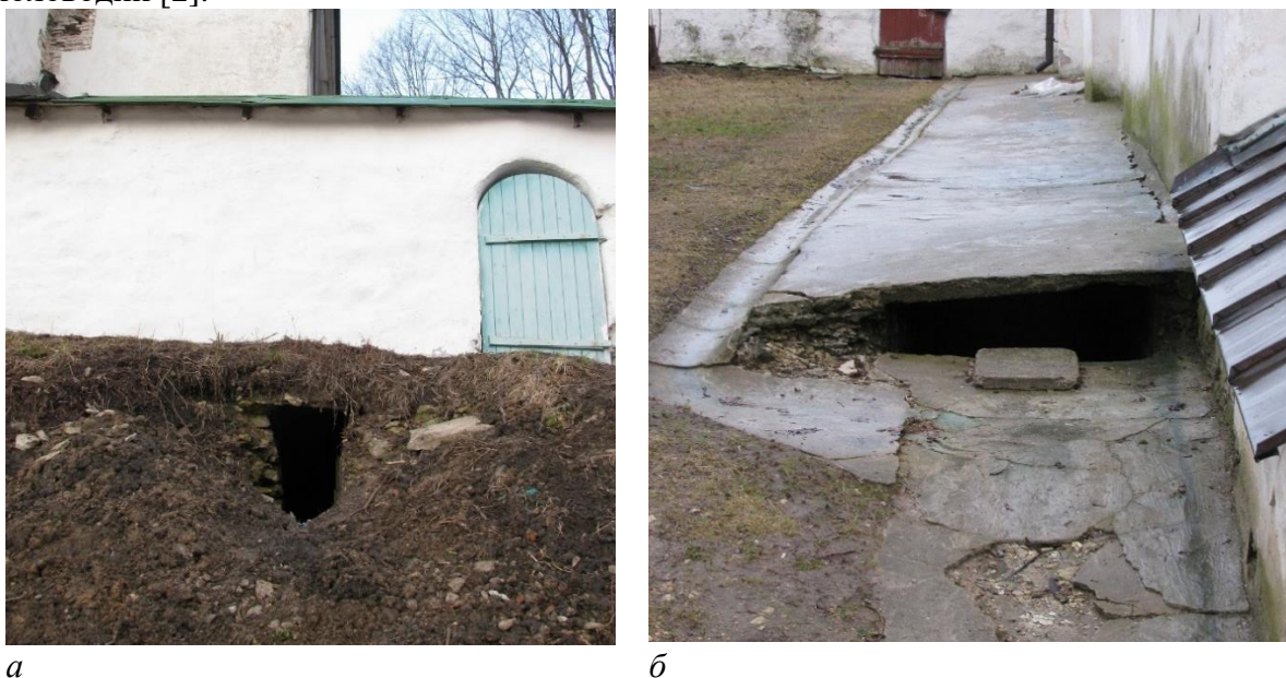
Рисунок 2. Дренажный тоннель вдоль северной стены Спасо-Преображенского собора Мирожского монастыря: а – выход на берег Великой; б – приёмное отверстие у стены собора внутри монастыря (Фото Вязковой О.Е.)
