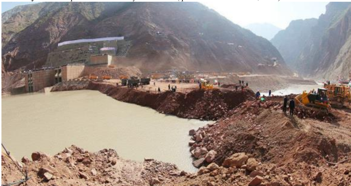
Рисунок 1. Строительство Рогунской ГЭС (фото Шокомолов Ш., 2018)
